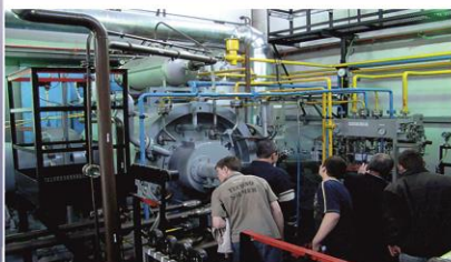
Изучение устройства нагнетателя ГПА-ПС-90 "Урал"
